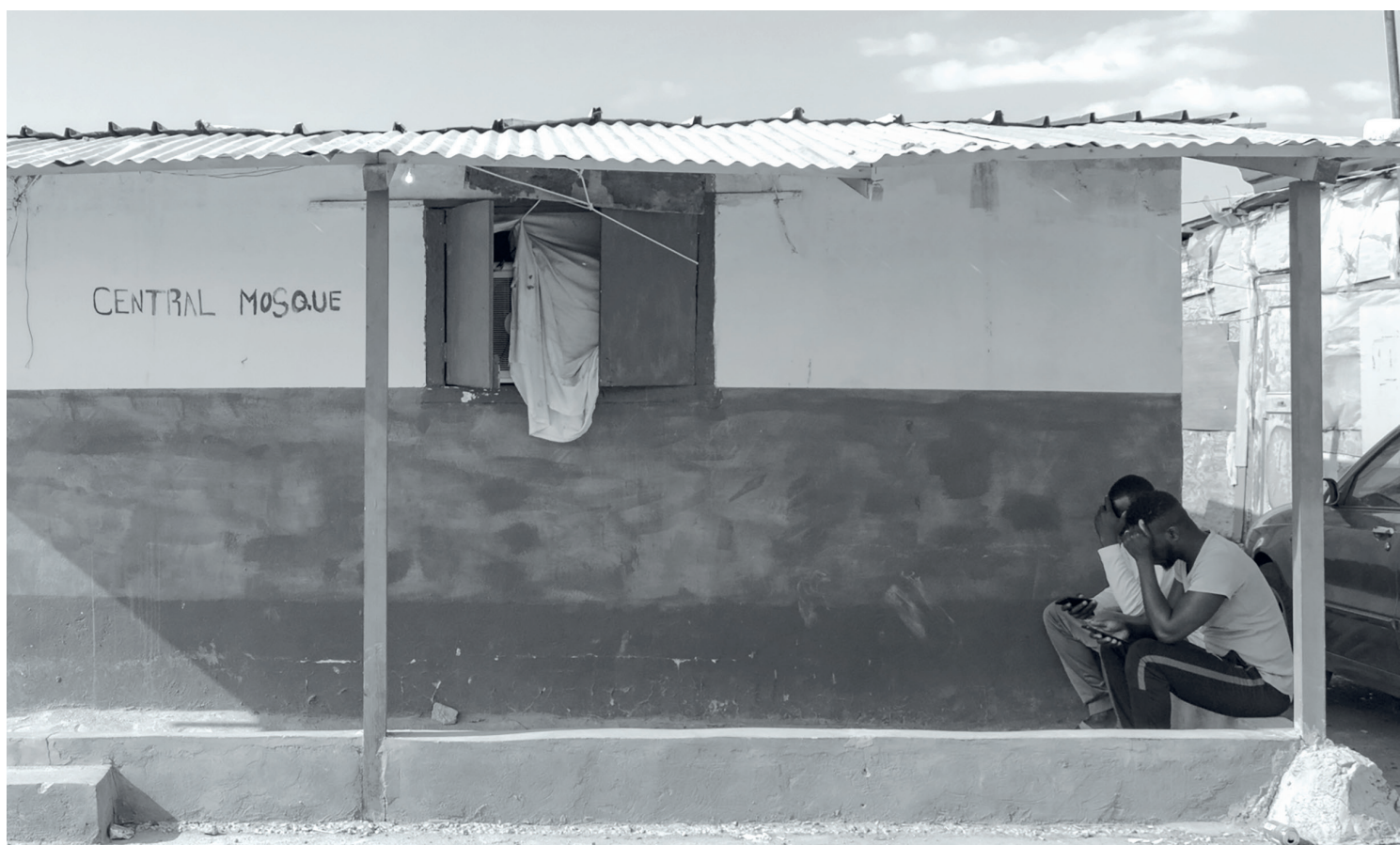
Moschea centrale nell'insediamento dell'ex Pista di Borgo Mezzanone
